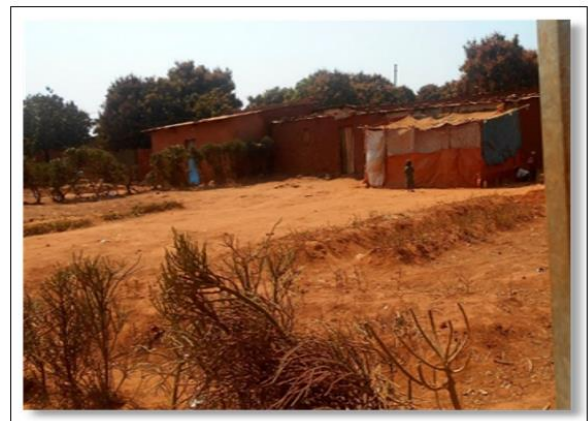
Photo 2 : Vue des maisons exposées à des risques de glissement de terrain à Luwowoshi.
